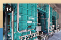
14 陶瓷膜 对河川及水源地水进行高度净化处理,使其成为饮用水。
