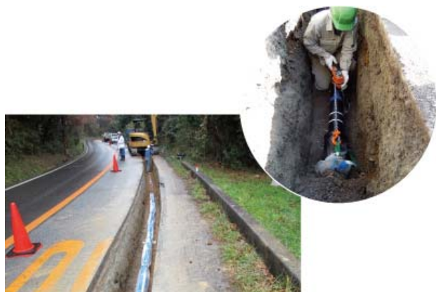
耐震管“NECS®”施工现场（日本大阪府能势町）
