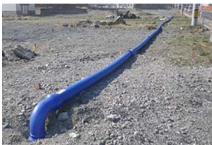
复合管（用于给排水管道、燃气管道等基础设施的修复和重建）
