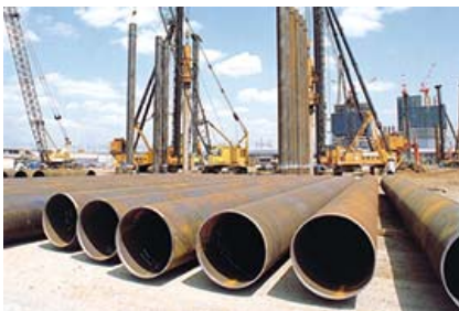
钢管 用于桥梁，港湾，河川，建筑物等基础设施。
