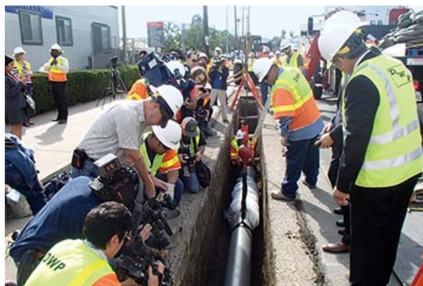
耐震管“GENEX®”施工现场（美国洛杉矶市）
