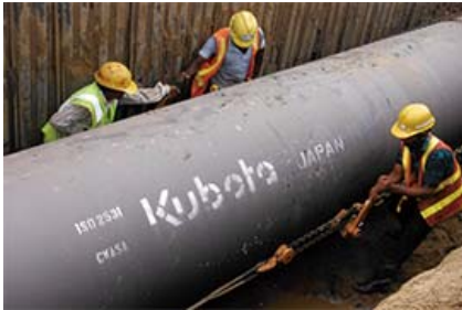
球墨铸铁管 ( 输水管 ) ( φ1,200mm ) 铺设施工 ( 孟加拉国 )
