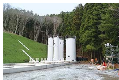
在建的预处理设备
