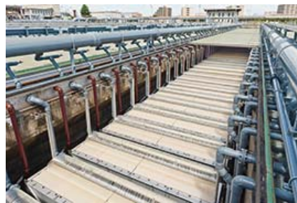
液中膜组件 对生活污水及工业废水等进行净化处理。
