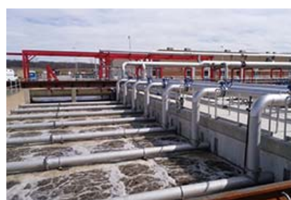
采用久保田膜处理装置的水再生处理设施 ( 上图：运转前；下图：运转时 )
