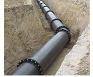
抗震型球墨铸铁管 NS型 公称直径 900
