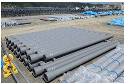
球墨铸铁管（用于给排水管道、燃气管道等基础设施的修复和重建）
