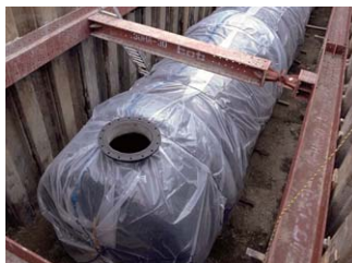
10 防震蓄水槽 为预防地震等灾害造成断水而储备饮用水。
