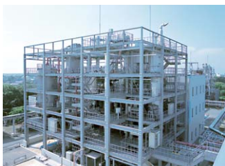
17 下水污泥焚烧炉 对下水处理时产生的污泥进行焚烧和熔融处理的成套设备。
