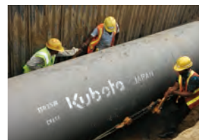
球墨铸铁管(输水管) ( \phi 1,200mm) 铺设施工(孟加拉国)
