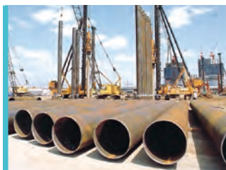
钢管 用于桥梁，港湾，河川，建筑物等基础施工。
