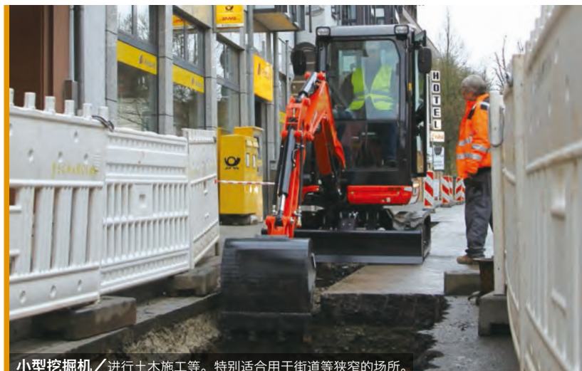
小型挖掘机 / 进行土木施工等。特别适合用于街道等狭窄的场所。
