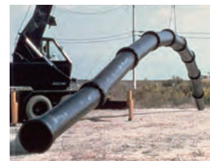
耐震连接件球墨铸铁管的起吊测试
