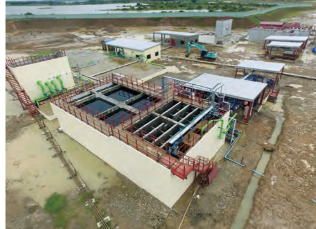
迪拉瓦工业园区 A区净水厂(缅甸)
