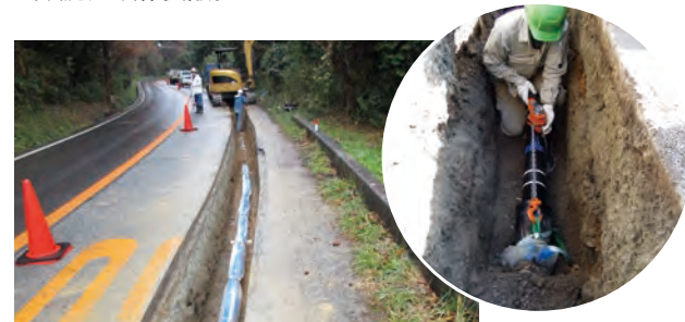
耐震管“NECS®”施工现场(日本大阪府能势町)
