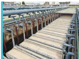
液中膜组件 对生活污水及工业废水等进行净化处理。
