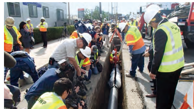
耐震管“GENEX®”施工现场(美国洛杉矶市)
