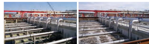
采用久保田膜处理装置的水再生处理设施(左图: 运转前; 右图: 运转时)
