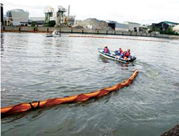
通过设置石油围栏,以防止油的扩散
