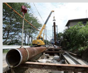
钢管 在桥梁基础、港湾、河川、建筑基础等多方面用作基础桩。
