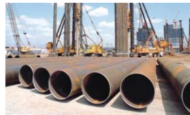
18 钢管 用于桥梁,港湾,河川,建筑物等基础施工。
