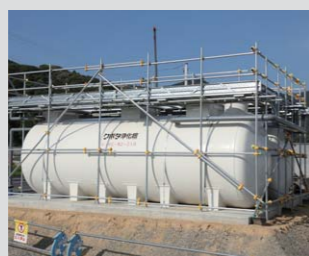
净化槽 对还未修复下水道的地区及临时住宅地区进行排水处理。
