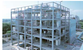
17 下水污泥焚烧炉 对下水处理时产生的污泥进行焚烧和熔融处理的成套设备。
