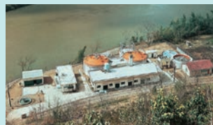
水处理事业部成立后首次承建的 广岛县三次市粪便处理设施
