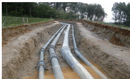
球墨铸铁管 用于给排水道和农业用水等基础设施。
