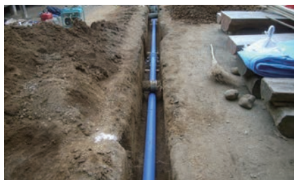
复合管 用于给排水道和煤气管道等基础设施。
