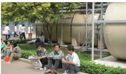
随着城市化推进，对给排水道、水处理设施的需求不断增加 (照片为在未完成下水道的地区大显身手的净化槽)
