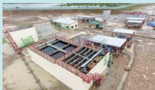
在迪拉瓦工业园区修建了净水厂
