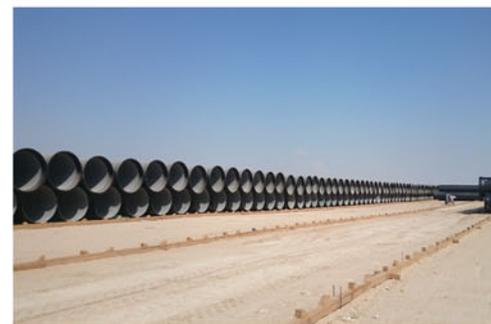
用作送水管的球墨铸铁管
