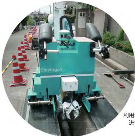
利用现场工作台进行配管施工
