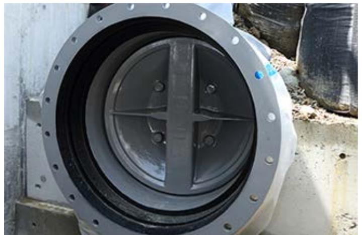
阀门（控制液体和气体，用于给排水管道、燃气管道等基础设施的修复和重建）
