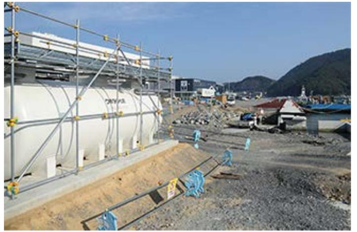
净化槽（对尚未修复下水道的地区及临时住宅地区进行排水处理）
