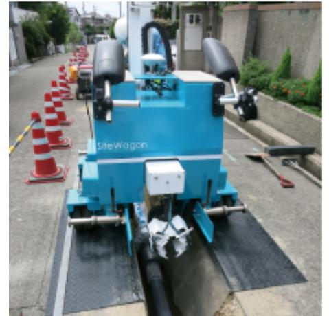
利用现场工作台进行配管施工
