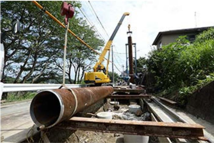
钢管（在桥梁基础、港湾、河川、建筑基础等多方面用作基础桩）
