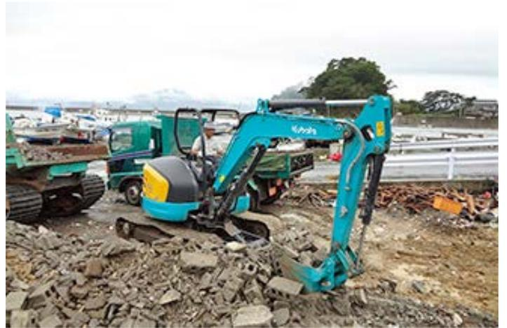
工程机械（用于清理废墟及拆除半损坏房屋等）
