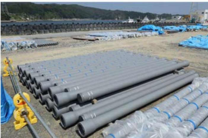
铁管（用于给排水管道、燃气管道等基础设施的修复和重建）
