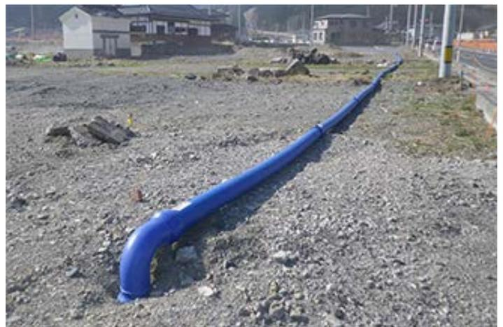
复合管（用于给排水管道、燃气管道等基础设施的修复和重建）
