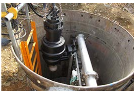
窨井水泵（加压输送污水）
