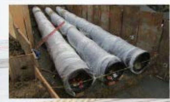
在日本积累的抗震管技术,也推广到地震频发的美国西海岸。 照片为大口径抗震管(公称直径1800mm等)的施工现场(美国加利福尼亚州硅谷地区)
