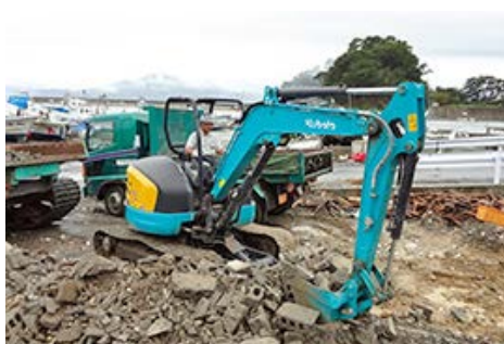
工程机械（用于清理废墟及各种土木工程等）
