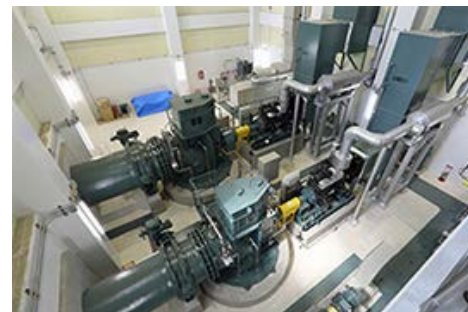
水泵（用于紧急排水，以及防止因大雨和大浪造成的水淹）
