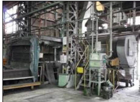
尼崎(ロール砂再生)
