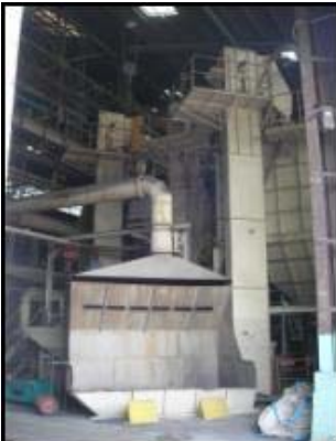
尼崎(異形管砂再生)
